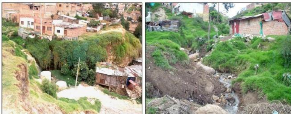
Fotografía 19 Remoción en masa en viviendas cercanas a la Quebrada Limas, arrastre de material.
